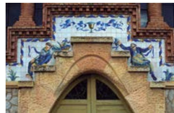
PINELL DE BRAI Maó, pedra, fusta, forja i rajoles vidriades, pintades per Xavier Nogués que decoren tota la façana del celler.
